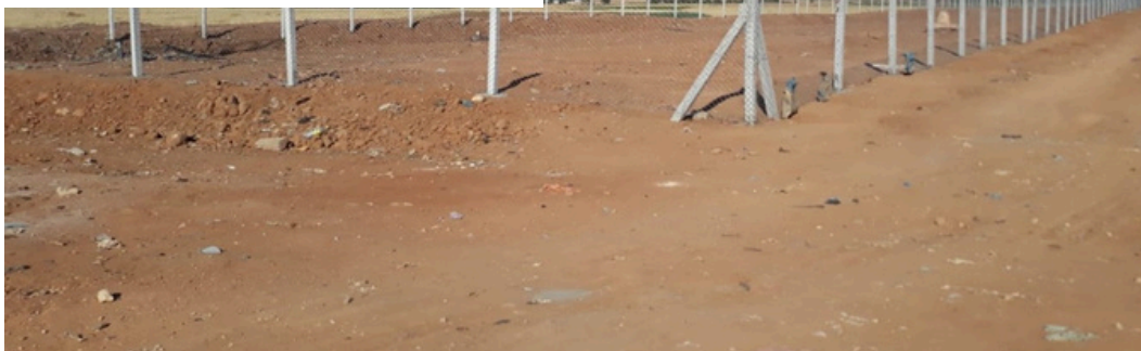
Décharge de Laaounate.
