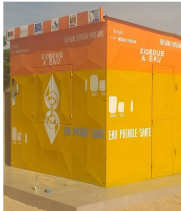
Kiosque à eau potable.
