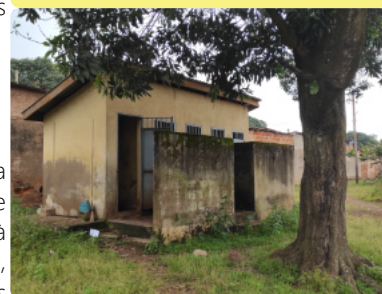
Bloc de latrines partagé entre deux écoles à Pita - 13/09/23
